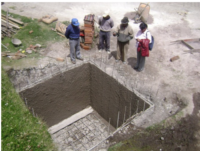
Bau eines Wassertanks/Reservoirs für die Schule Oswaldo Guayasamín in Secao (Chimborazo)
