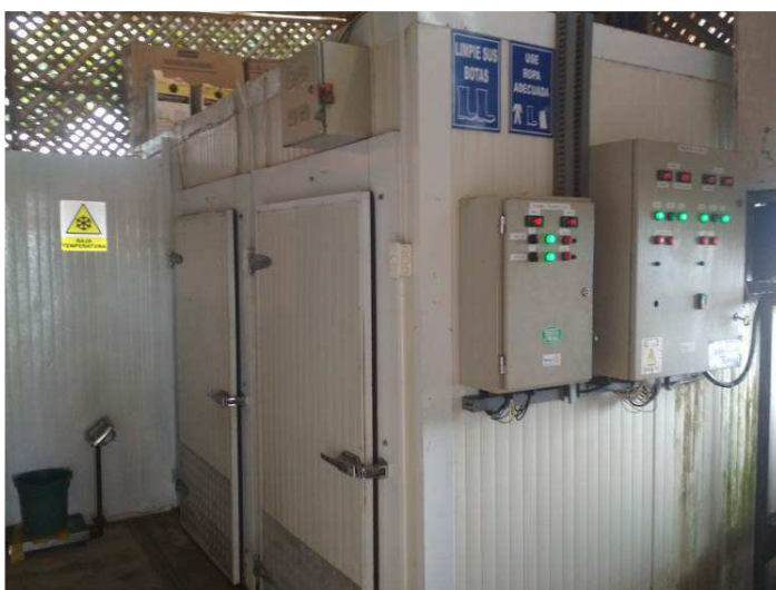
Las cámaras frigoríficas para almacenar el hielo producido y almacenar el pescado
