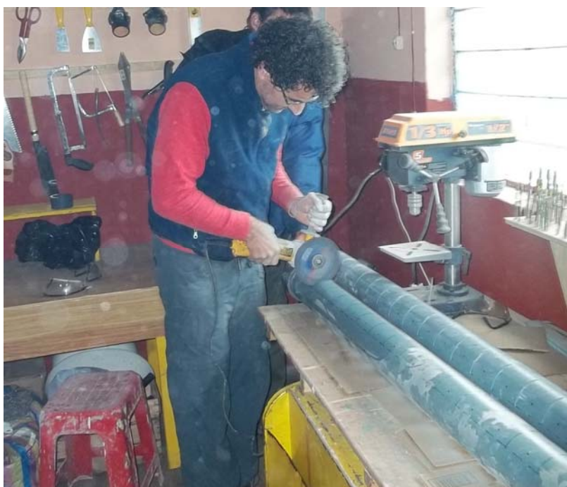
Foto 3: realizzazione tubo dreno
