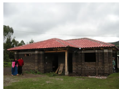
Il nuovo centro artigianale di Cochaloma, costruito in "adobe" mattoni di terra senza cemento, per recuperare i sistemi di costruzione tradizionali.
